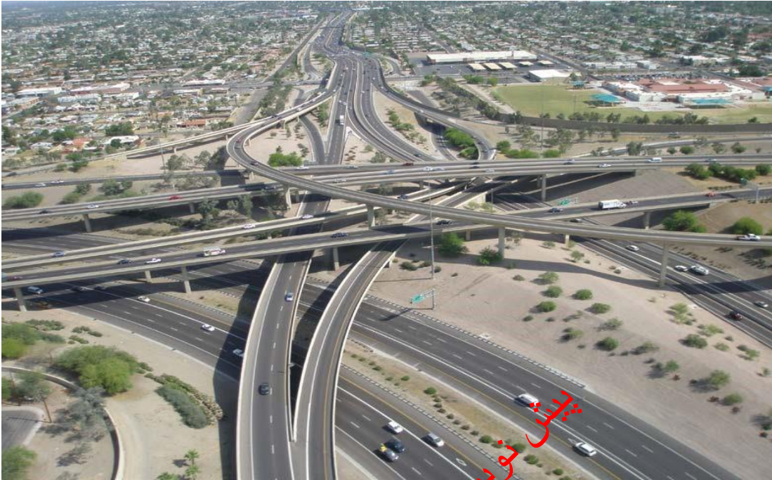
شکل ۶-۳۸- تبادل جهتی چهار سطحی
